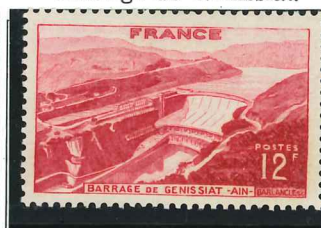
Barrage de Génissiat.
