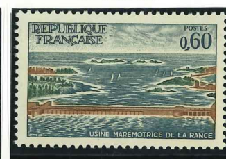
Usine marémotrice de la Rance.
