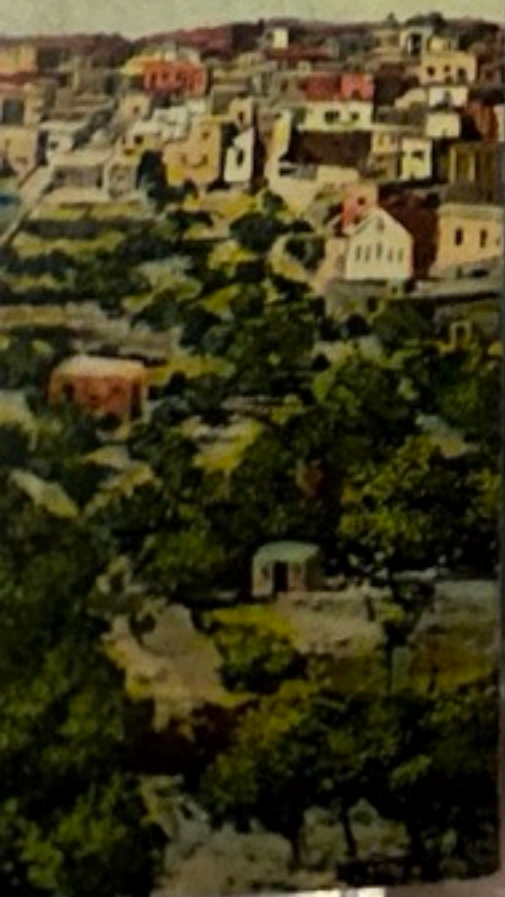
BETHLÉHEM - Vue Général. General view. Gesamtansicht.
