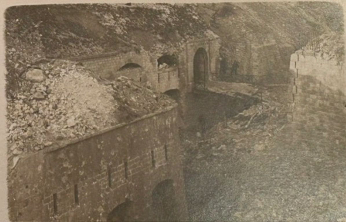
Fort de Liouville après le bombardement de Septembre 1914. L'entrée du fort - L'évacuation (nuit de 29 au 30 septembre) se fit par l'ouverture sous le pont.
