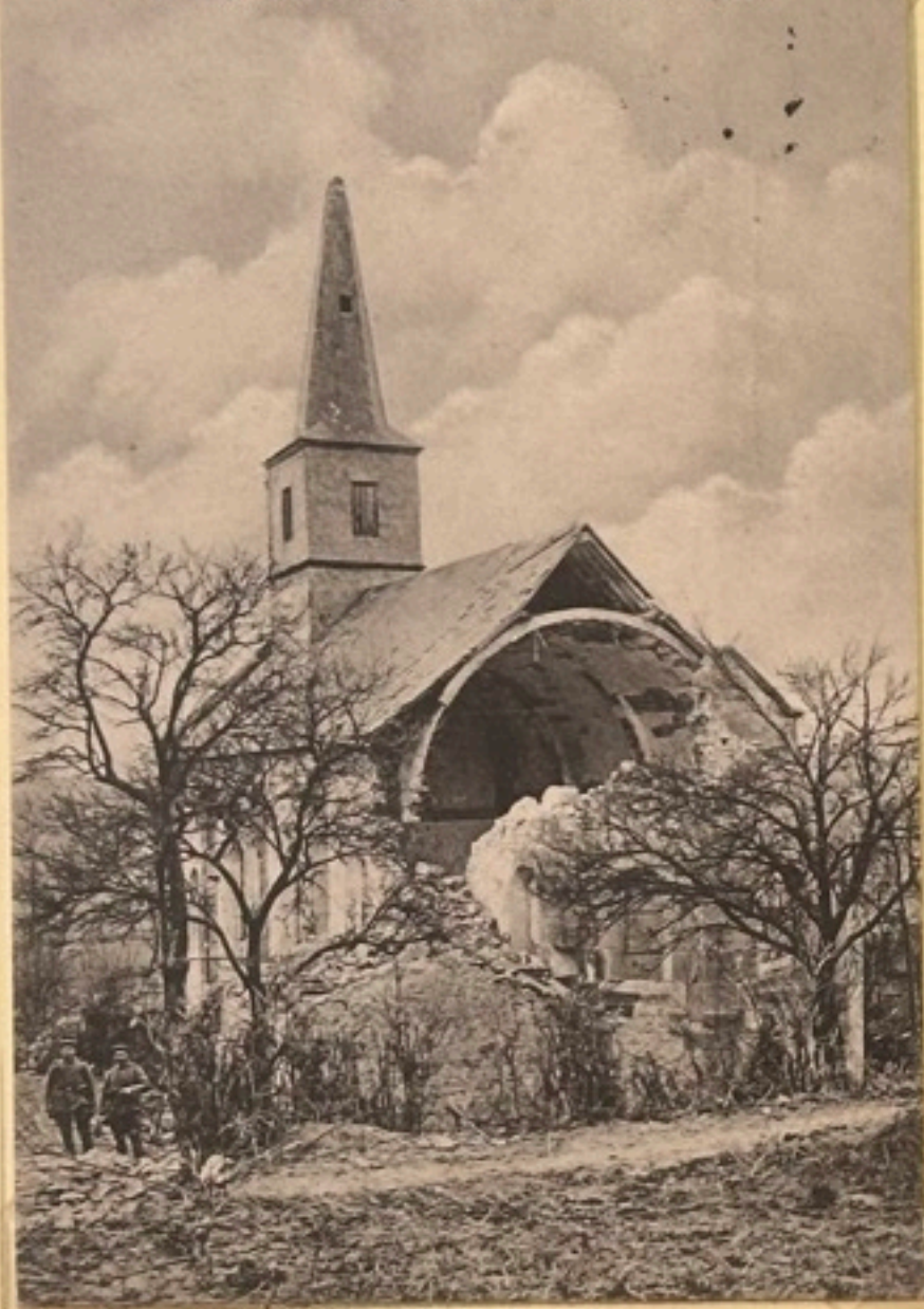
Charpentry, wurde von Engländern und Franzosen zerstört.
