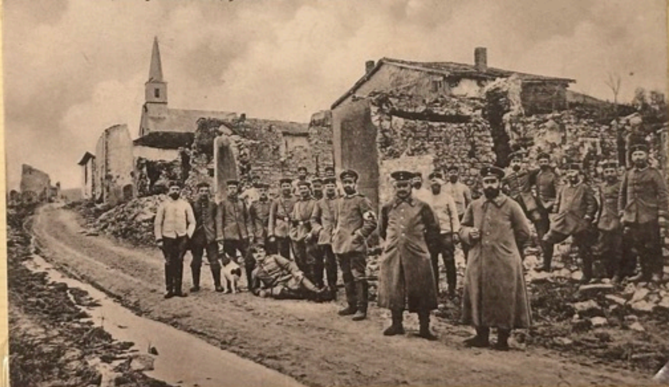
Charpentry, wurde von Engländern und Franzosen zerstört.
