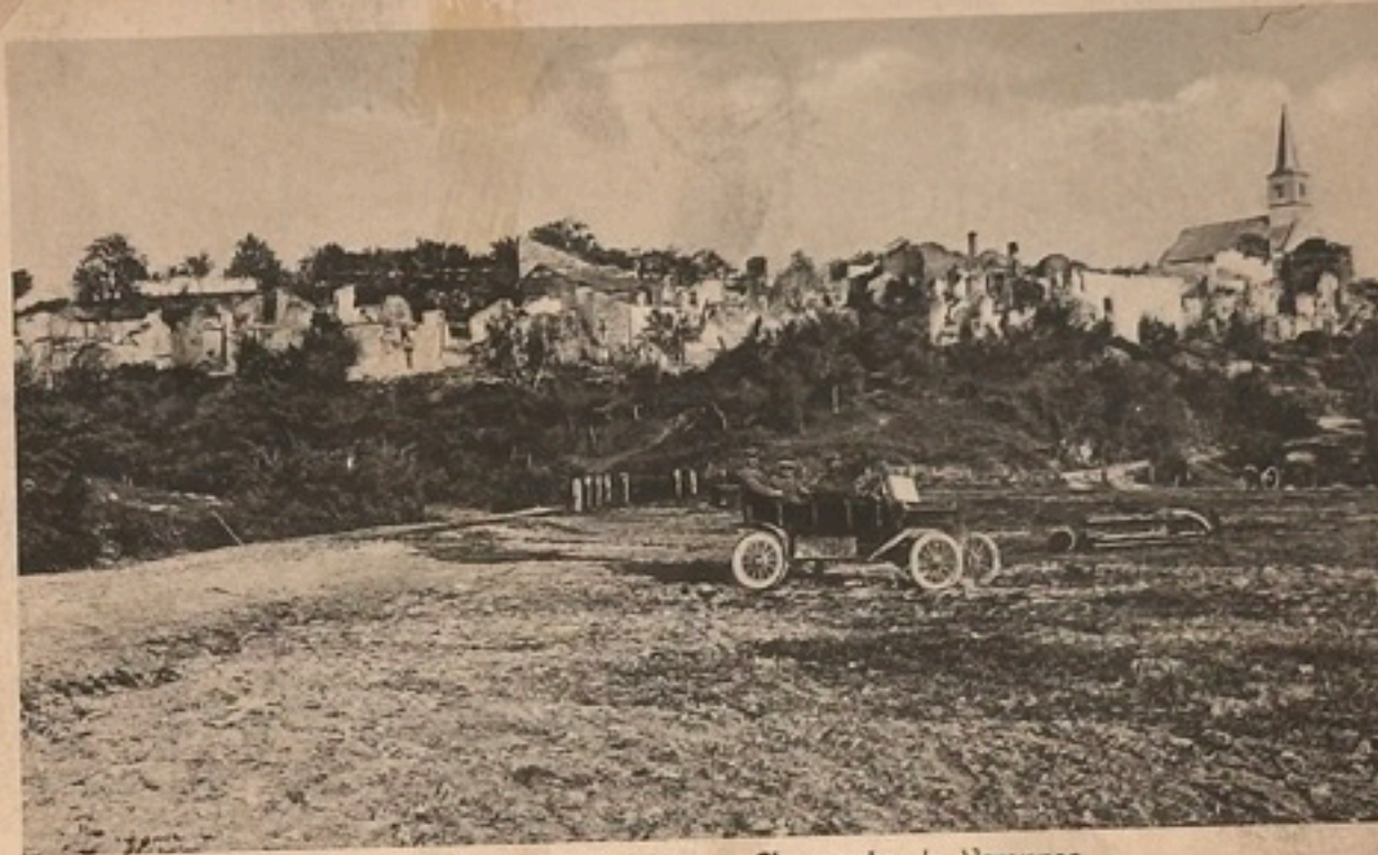
Westlicher Kriegsschauplatz - Charpentry b. Varennes
