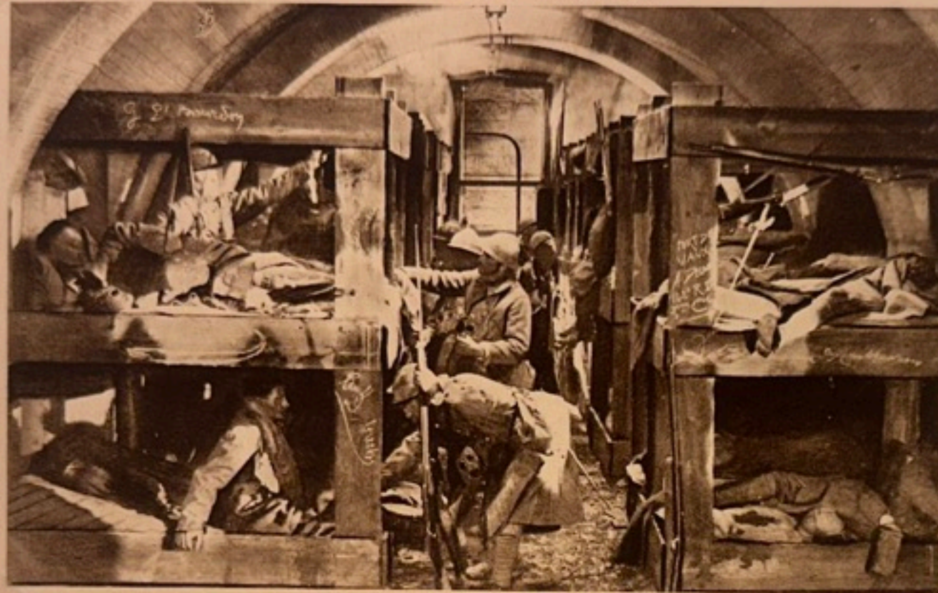
La " Caserne " souterraine du Fort de Vaux
