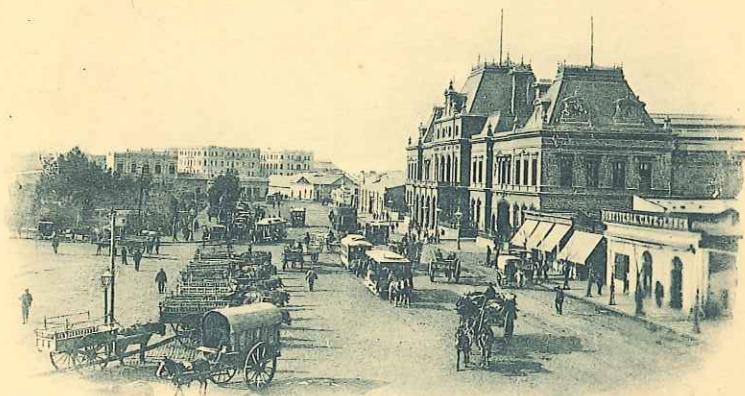
ESTACION F. C. DEL SUD
