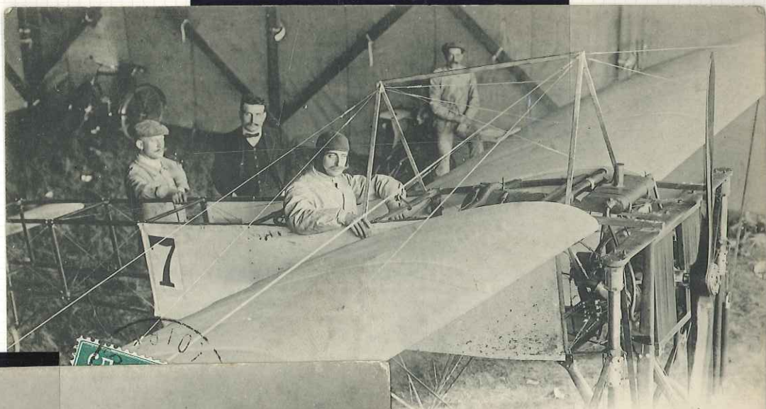
1. - Grande Semaine d'Aviation d'ANGERS. - 3, 4, 5, 6 Juin 1910. - L. V., phot. Emile Aubrun, sur monoplane Blériot, type traversée de la Manche, Bayard-Clement, 2 cylindres horizontaux, 31 HP, hélice tractrice en noyer, 2 m 10 diamètre, poids 250 klogs, ordre de marche, vitesse 100 mètres à l'heure.
