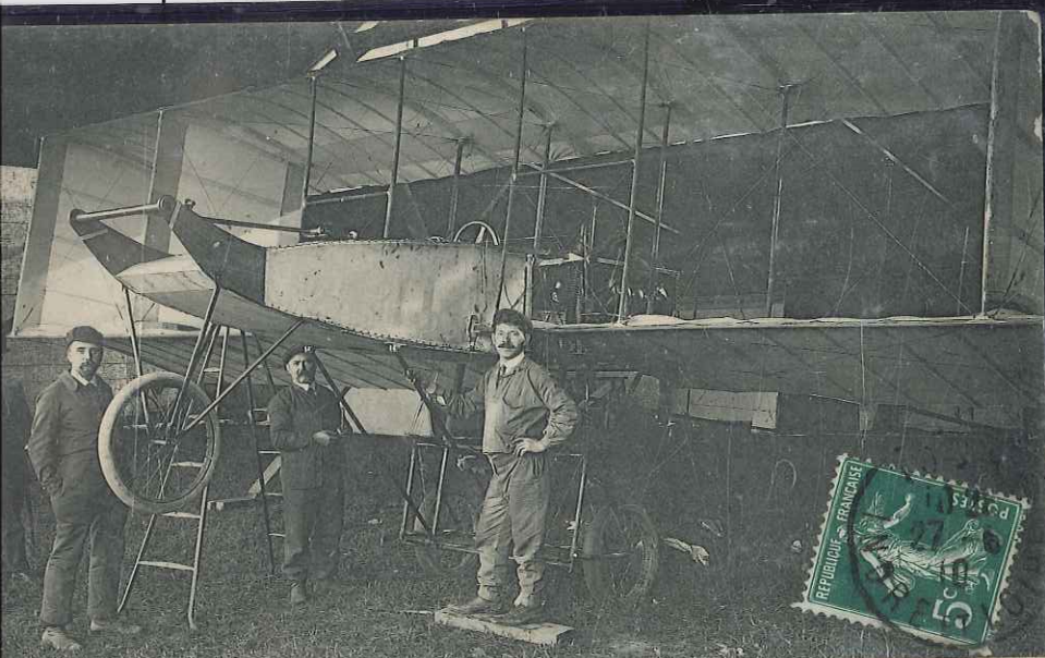
SEMAINE D'AVIATION DE TOURAINE (30 avril - 5 mai 1910). — Édition officielle. (ND Phot.) 3 — ALLARD procède au montage de son biplan Voisin, 10 m. d'envergure; moteur E.N.V. de 55 HP.
