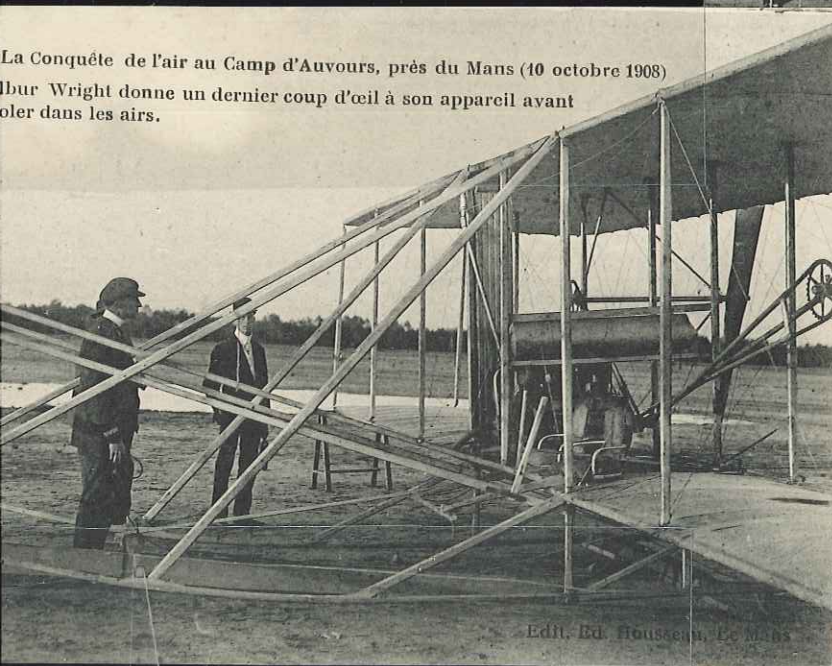
La Conquête de l'air au Camp d'Auvours, près du Mans (10 Octobre 1908) L'aéroplane de Wilbur Wright, vu par l'arrière (on remarque le gouvernail, les deux hélices, le moteur et les plans de suspension)
